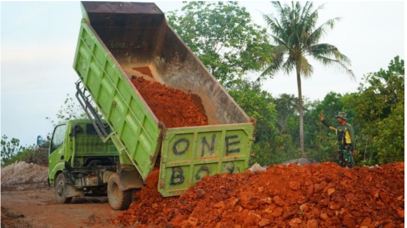
Percepat Pengerjaan Jalan, Material Dan Alat Terus DiKebut Satgas TMMD Di Tarakan
