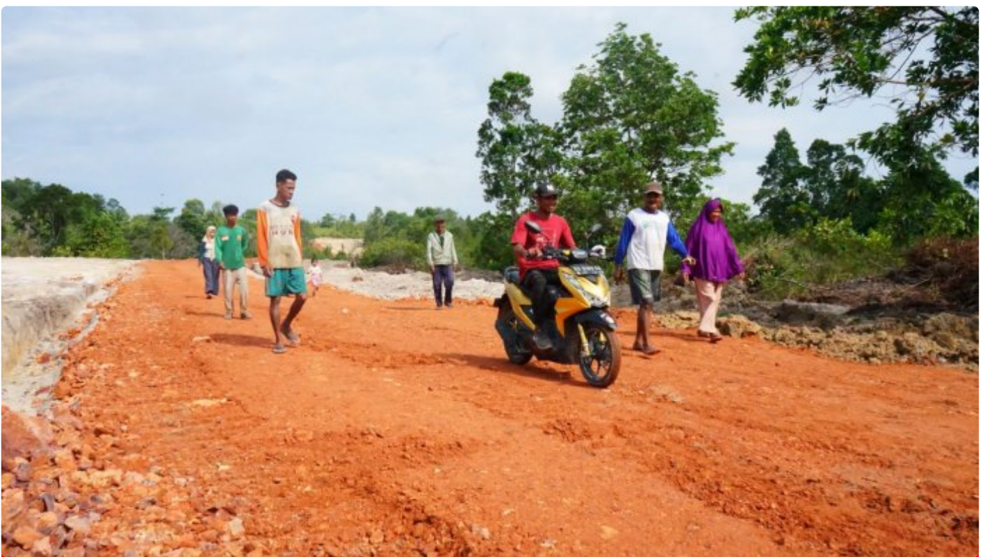
Pembukaan Jalan Rampung 100 Persen, Warga Berbondong-Bondong Datang Ke Lokasi
